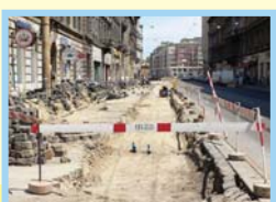
Thököly út: A lefejtett AVK szerelvények helyét már csak néhány kezelő-szár-vég jelzi
