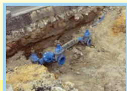
Budakeszi út: AVK szerelvények beépítés közben
