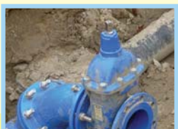
Budakeszi út: Fővezeték leágazás megvalósítása előtt
