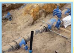
Budakeszi út: AVK szerelvények – nyomáspróba előtt
