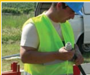
PLASSON mechanikus gyorskötők szerelése: gyorsan – könnyen – egyszerűen – szerszám nélkül
