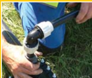
PLASSON mechanikus gyorskötők szerelése: gyorsan – könnyen – egyszerűen – szerszám nélkül
