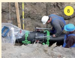
4 A csőkötést létrehozó speciális szerszámok és eszközök előkészítése
