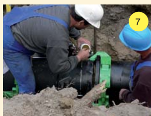
3 A csövet védő védőburkolat eltávolítása – a csőkötést megelőző, utolsó munkafázisban
