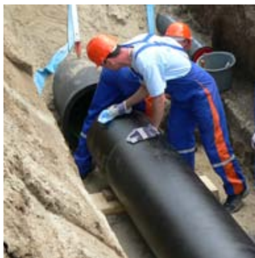
A csővégek tisztítása és kenőanyaggal történő ellátása
