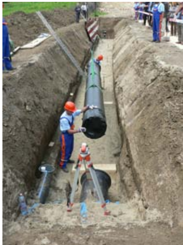
A csőszál beemelése a munkáárokba gépi segítséggel
