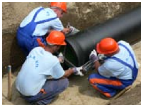
Végleges behúzás és helyre illesztés – csőrő segítségével
