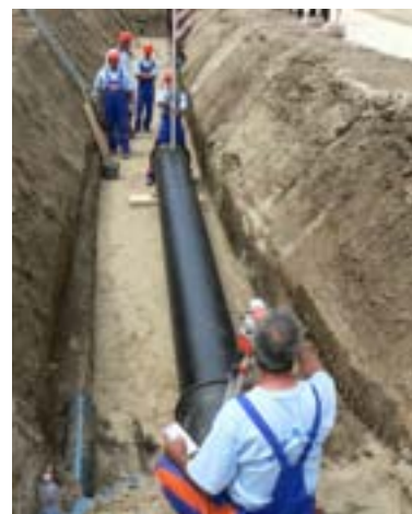
Szintezés és iránybeállítás teodolittal
