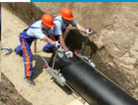
Végleges behúzás és helyre illesztés – csőrő segítségével
